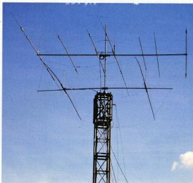
Obr. 9. ...a současný stav – po rekonstrukci (vpravo)
